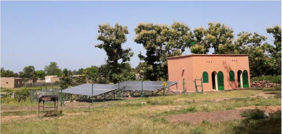
**Kiosque solaire.** Les plateformes multifonctionnelles solaires se rencontrent dans tous les pays sahéliens. Un système de stockage par des batteries est prévu, afin de résoudre le problème de l'intermittence diurne/nocturne et de compenser le décalage entre la demande et l'intensité de la radiation solaire.
